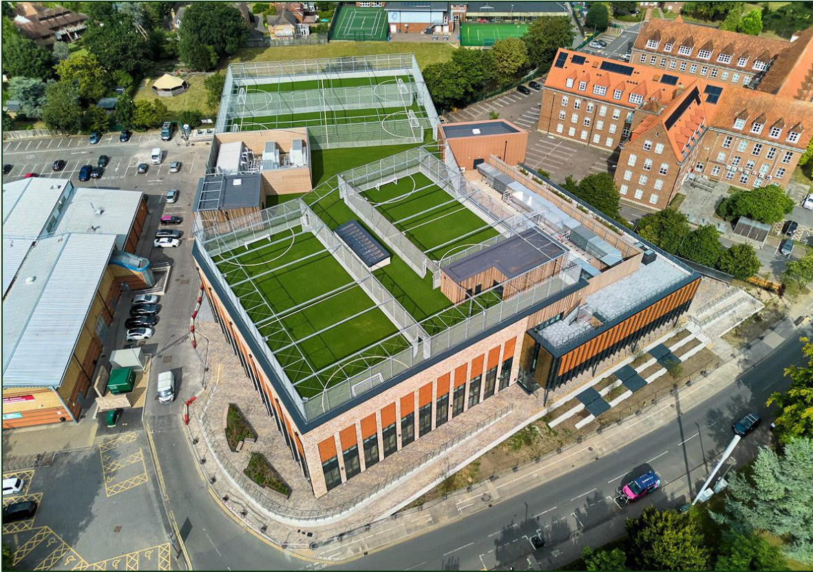
Figure 1: Passivhaus 'Eclipse Leisure Centre'
